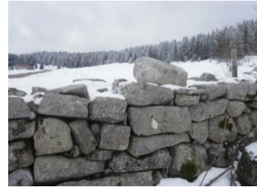
Les murets /murgers
